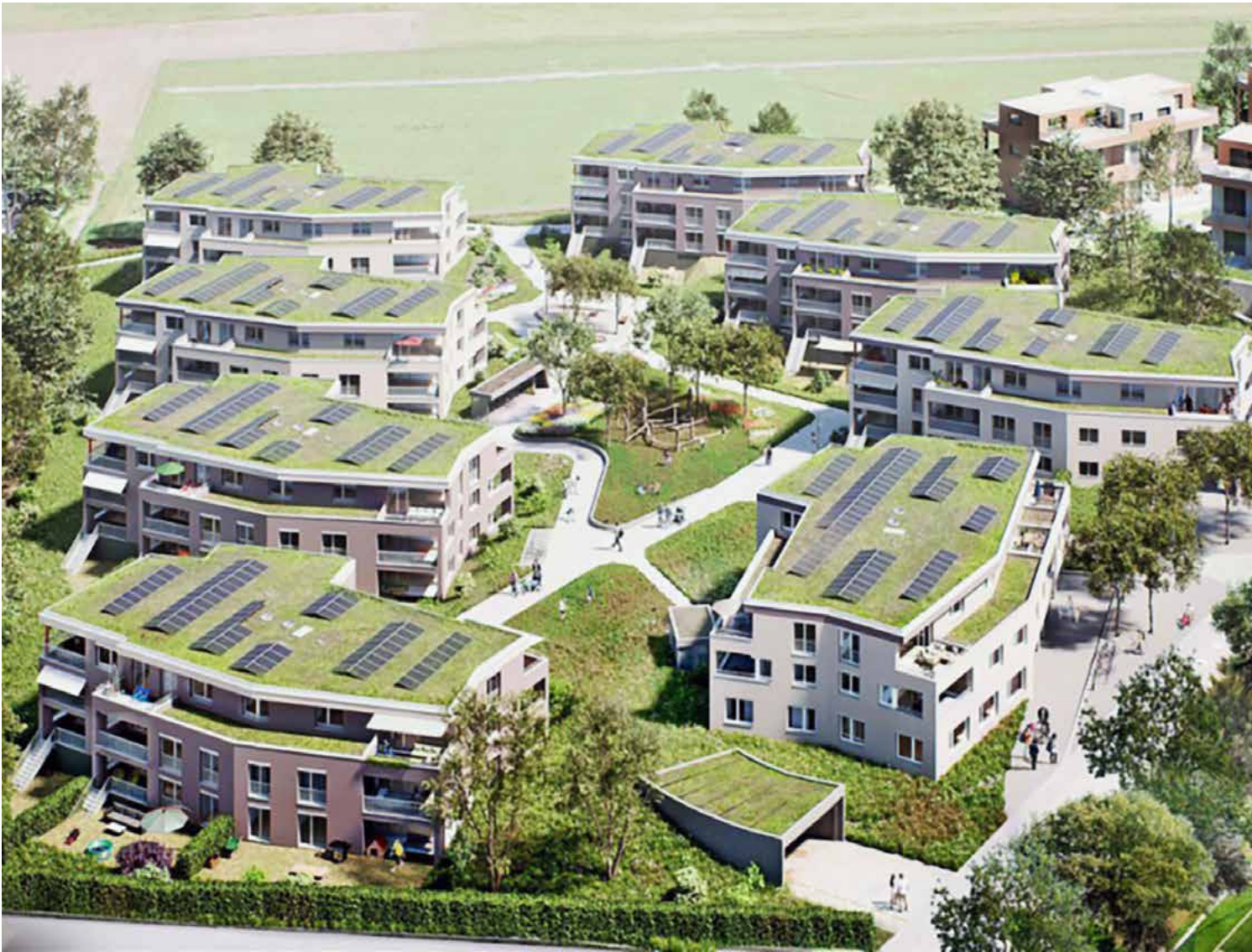
Drohnenaufnahme von der geplanten Überbauung.
